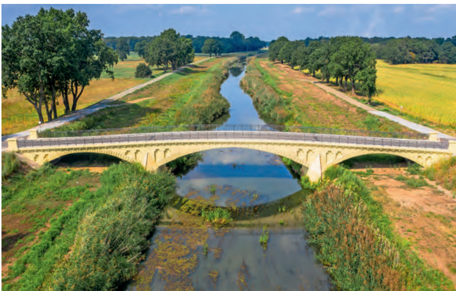
Einer der drei Sonderpreise 2021: Gewölbebrücke über die Schwarze Elster
