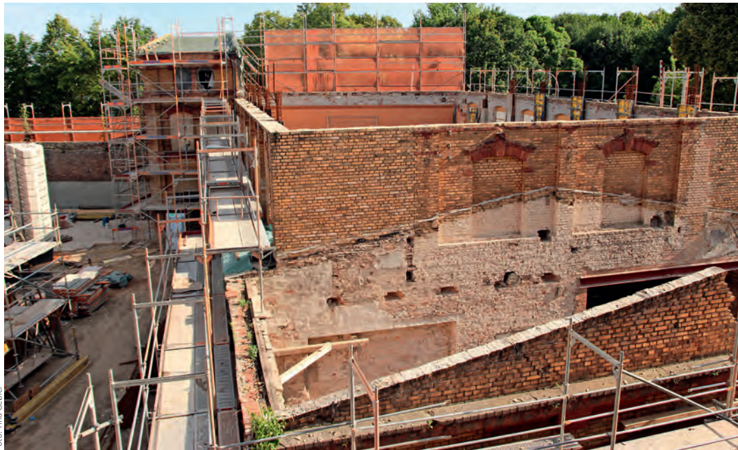
Die Aufstockung des Nebengebäudes ist in vollem Gange.
