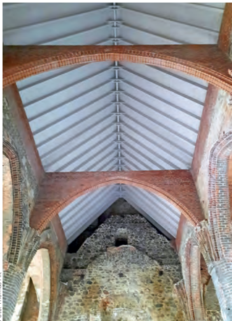
Untersicht in das neue Mittelschiffsdach
